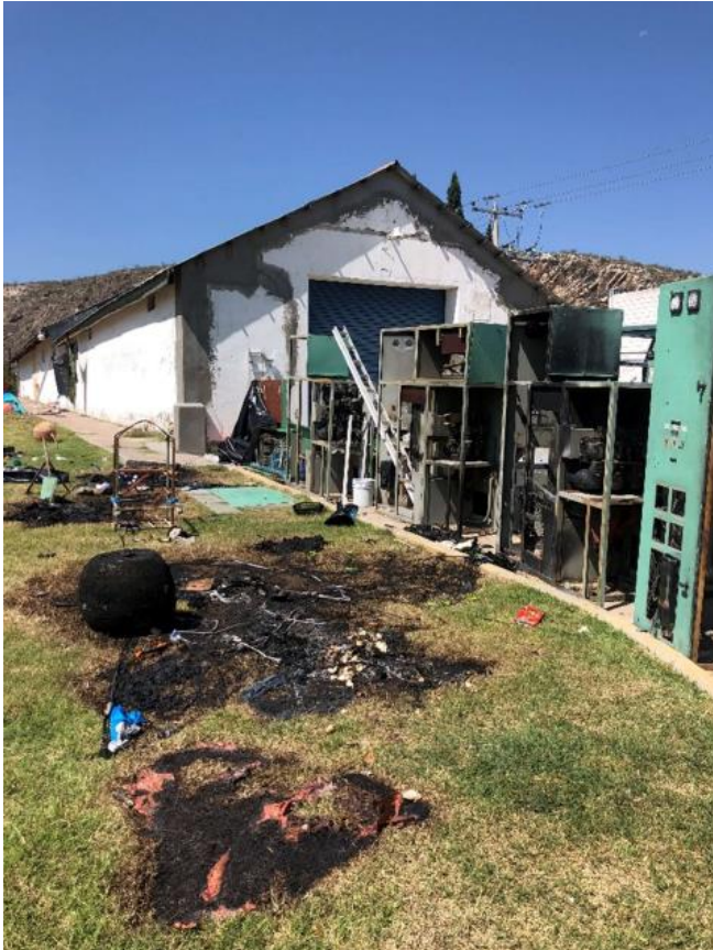
Destrozos en almacenes de la Central. Vista bodega de chatarra.
