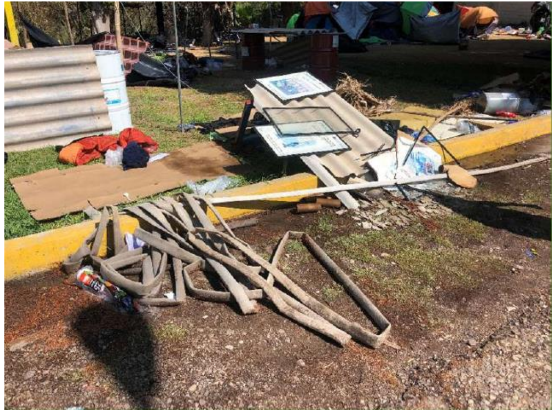
Daños a caseta de almacenamiento de residuos temporales de la Central.
